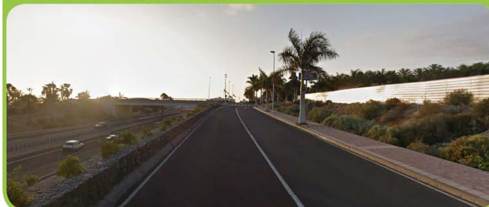
FOTO DEL ESTADO ACTUAL DE LA INTERVENCIÓN
