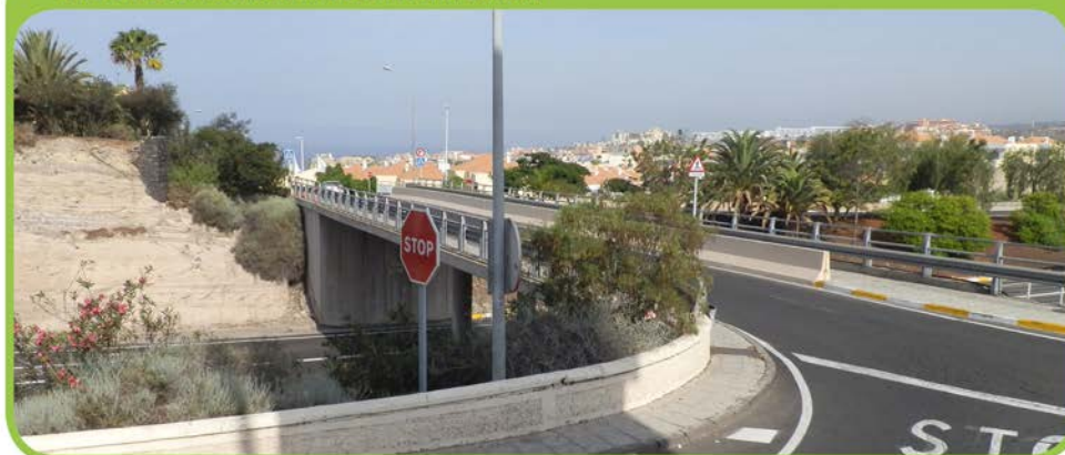
FOTO DEL ESTADO ACTUAL DE LA INTERVENCIÓN
