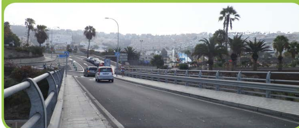
FOTO DEL ESTADO ACTUAL DE LA INTERVENCIÓN
