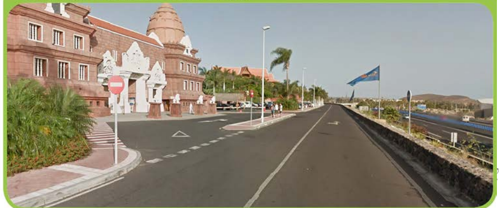
FOTO DEL ESTADO ACTUAL DE LA INTERVENCIÓN
