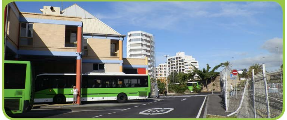
FOTO DEL ESTADO ACTUAL DE LA INTERVENCIÓN
