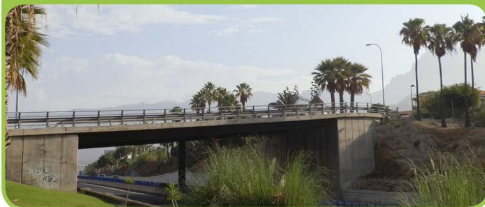
FOTO DEL ESTADO ACTUAL DE LA INTERVENCIÓN
