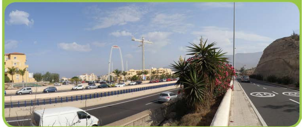
FOTO DEL ESTADO ACTUAL DE LA INTERVENCIÓN
