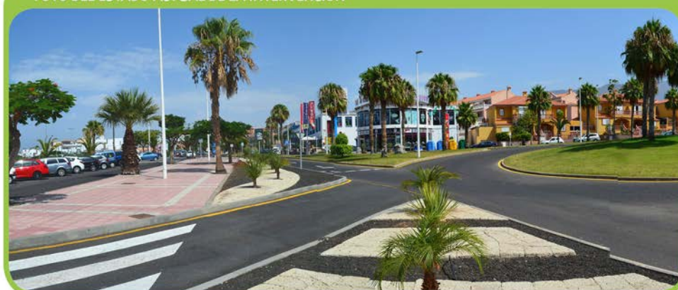
FOTO DEL ESTADO ACTUAL DE LA INTERVENCIÓN
