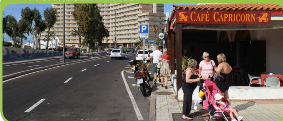
FOTO DEL ESTADO ACTUAL DE LA INTERVENCIÓN
