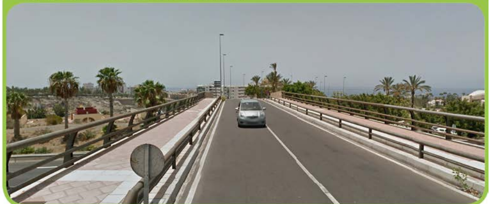
FOTO DEL ESTADO ACTUAL DE LA INTERVENCIÓN
