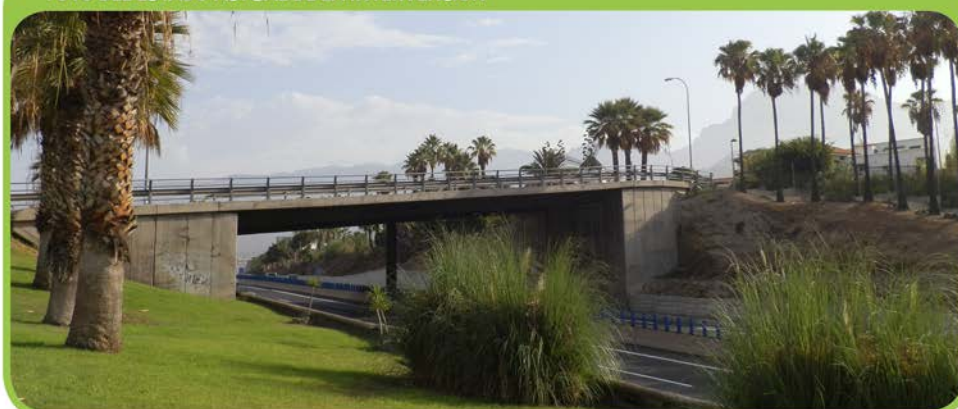
FOTO DEL ESTADO ACTUAL DE LA INTERVENCIÓN
