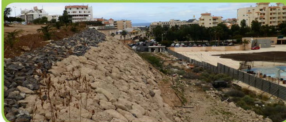
FOTO DEL ESTADO ACTUAL DE LA INTERVENCIÓN
