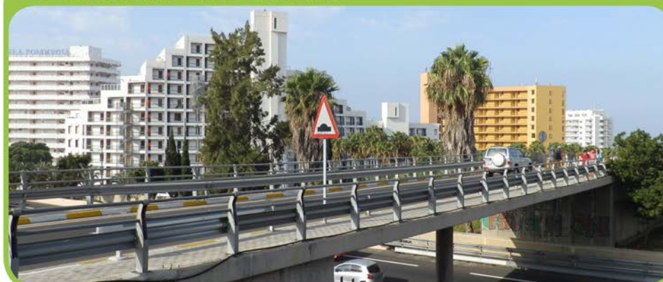
FOTO DEL ESTADO ACTUAL DE LA INTERVENCIÓN
