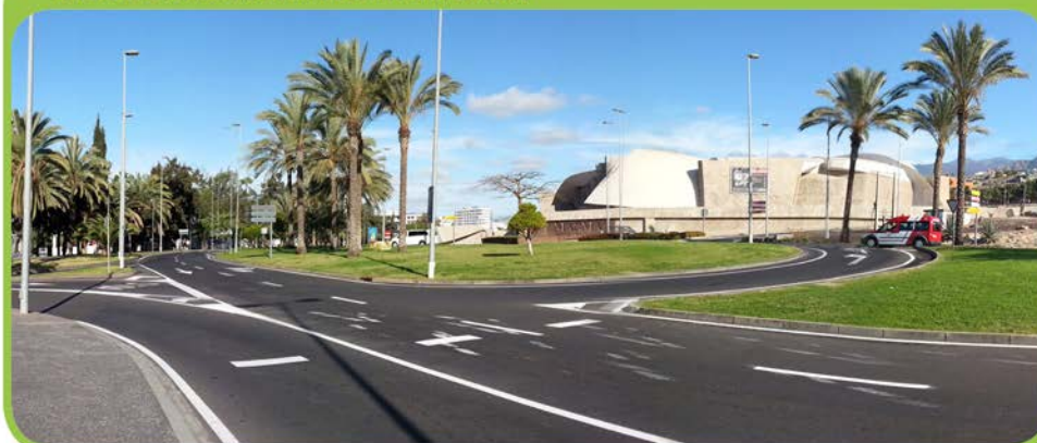
FOTO DEL ESTADO ACTUAL DE LA INTERVENCIÓN
