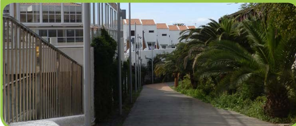
FOTO DEL ESTADO ACTUAL DE LA INTERVENCIÓN
