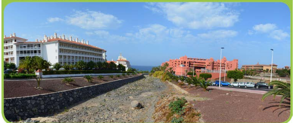
FOTO DEL ESTADO ACTUAL DE LA INTERVENCIÓN
