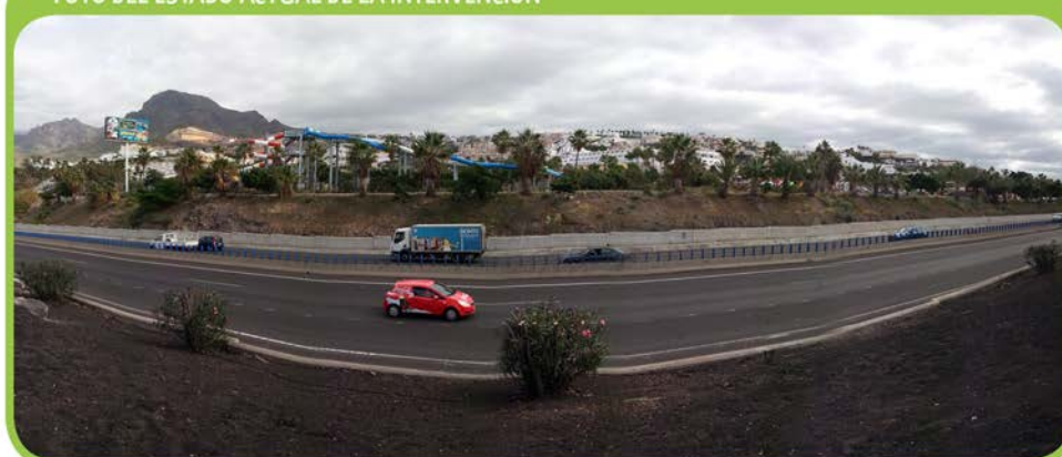
FOTO DEL ESTADO ACTUAL DE LA INTERVENCIÓN
