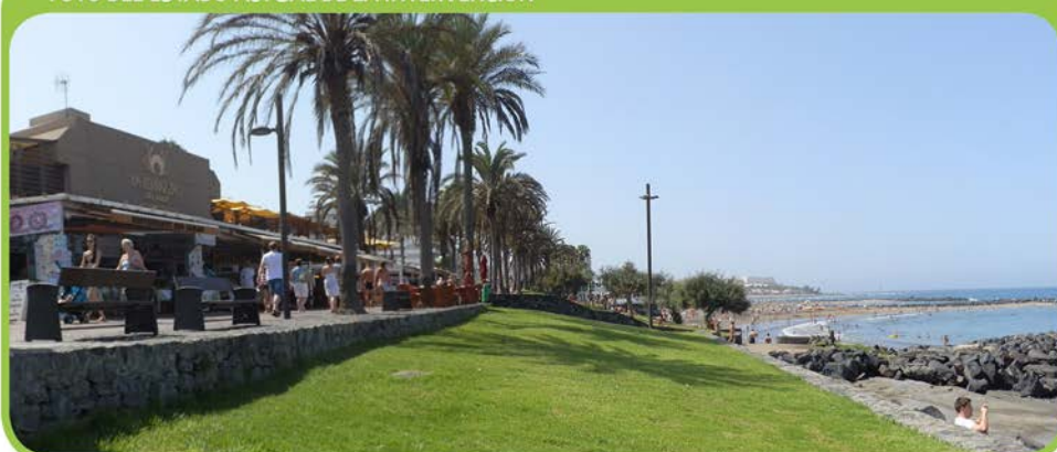
FOTO DEL ESTADO ACTUAL DE LA INTERVENCIÓN
