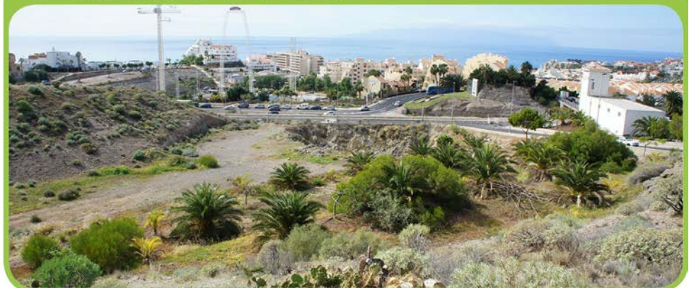
FOTO DEL ESTADO ACTUAL DE LA INTERVENCIÓN
