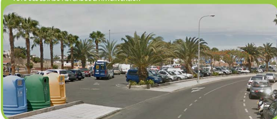
FOTO DEL ESTADO ACTUAL DE LA INTERVENCIÓN
