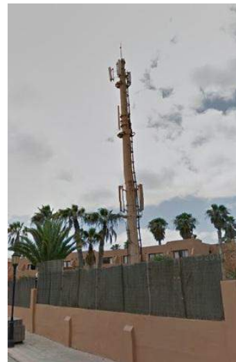
Antena con escasa integración visual
