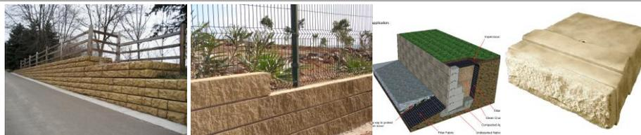
Materiales: piezas prefabricadas de gran formato de hormigón, tipo bloque, con acabado abujardado.
